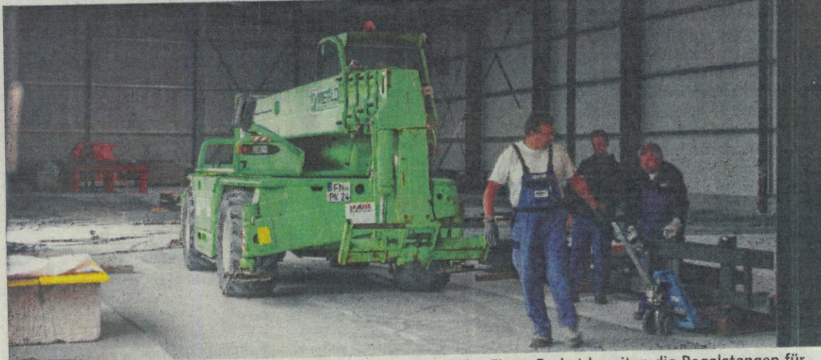
Die Arbeiten in der neuen Halle sind voll im Gang. Mitarbeiter der Firma Probst bereiten die Regalstangen für Pelletieranlage vor.
